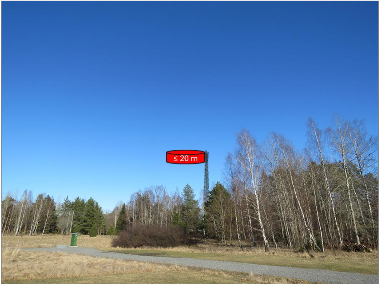
Figur 2. Driftzonen för antennerna sträcker sig upp till 20 meter rakt framför antennerna och utgör därmed ingen risk för allmänheten.
